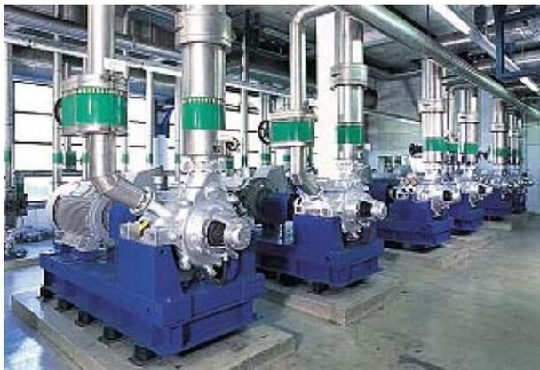
Bild 1.6: Asynchronmaschinen als Antrieb für Kompressoren.
